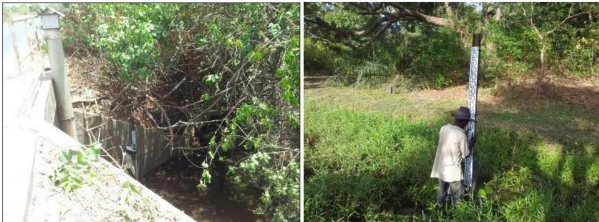
**Figure 41:** Echelle réhabilitée de Néma Nding et échelle de Néma Ba (élément 0-1m et 1-2 m) (DGPPE, 2014)
